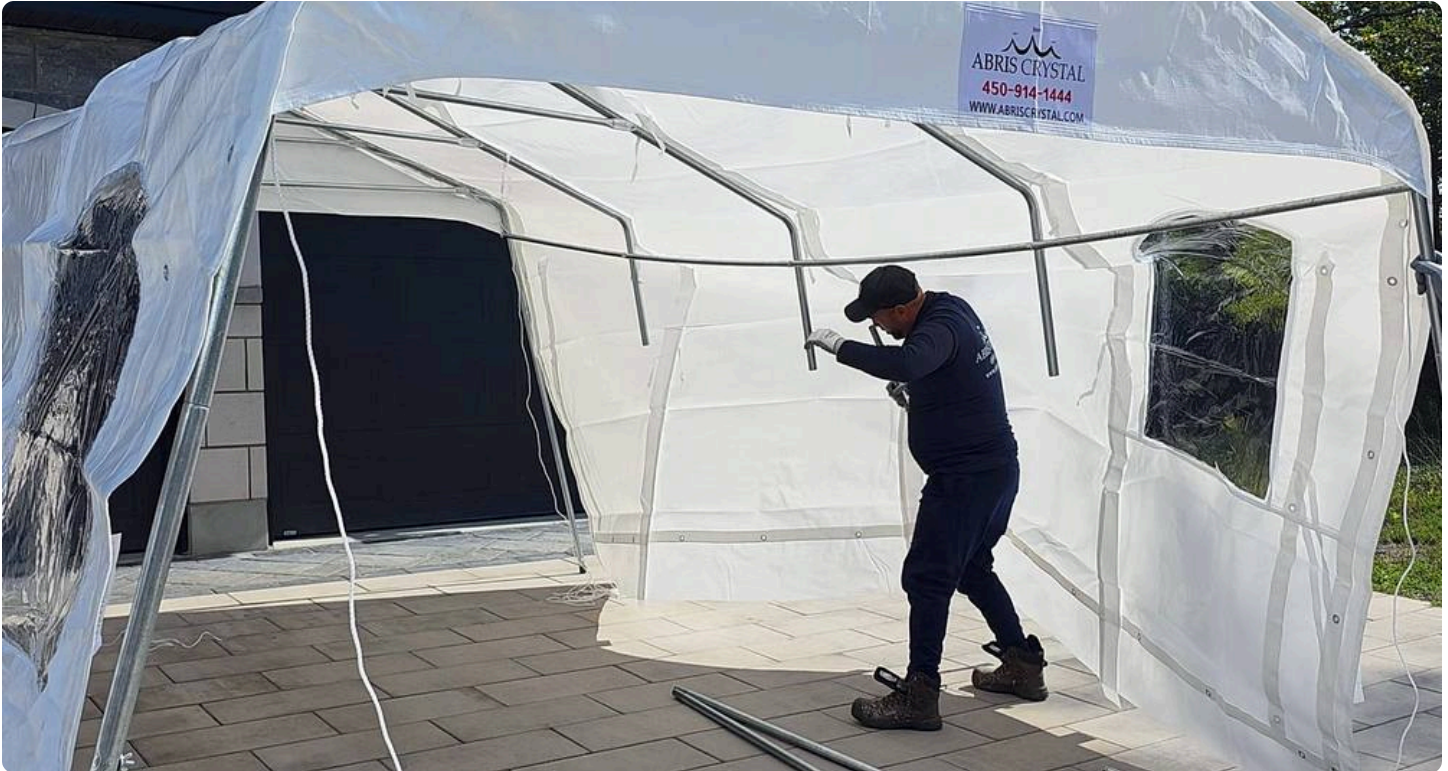
Le 2 e côté se lève, toile en place / The 2nd side goes up, tarp in place
