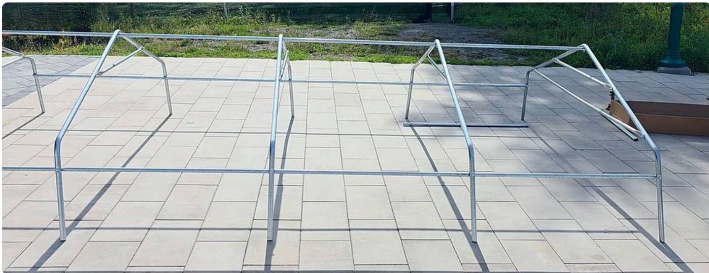
Les arches debout, reliées par le haut / The arches standing, joined at the top
