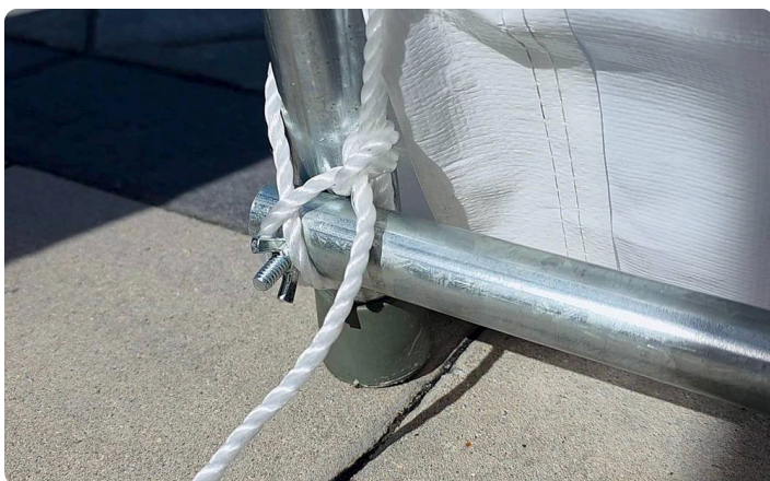
Cordons attachés à chaque section / Cords tied at each section
