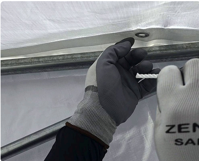
Corde dans les œillets / Rope through the grommets
