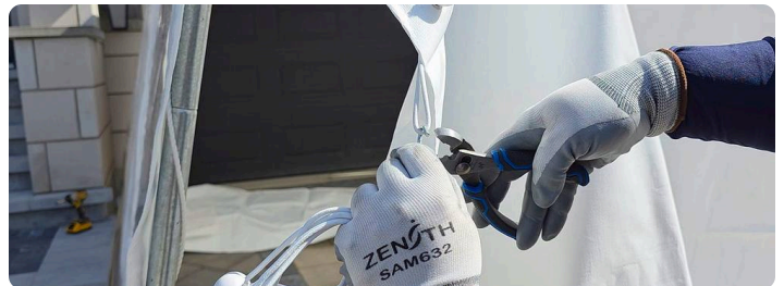
Refermez le S avec une pince / Close the S with pliers
