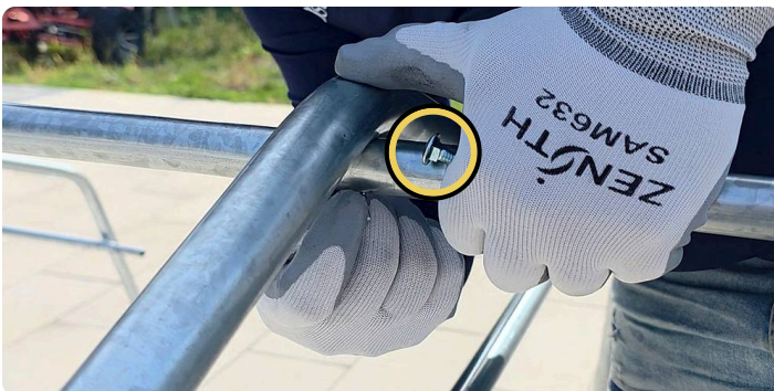
Entretoise boulonnée à l'arche : B2 + W1 / Spacer bolted to the arch: B2 + W1
