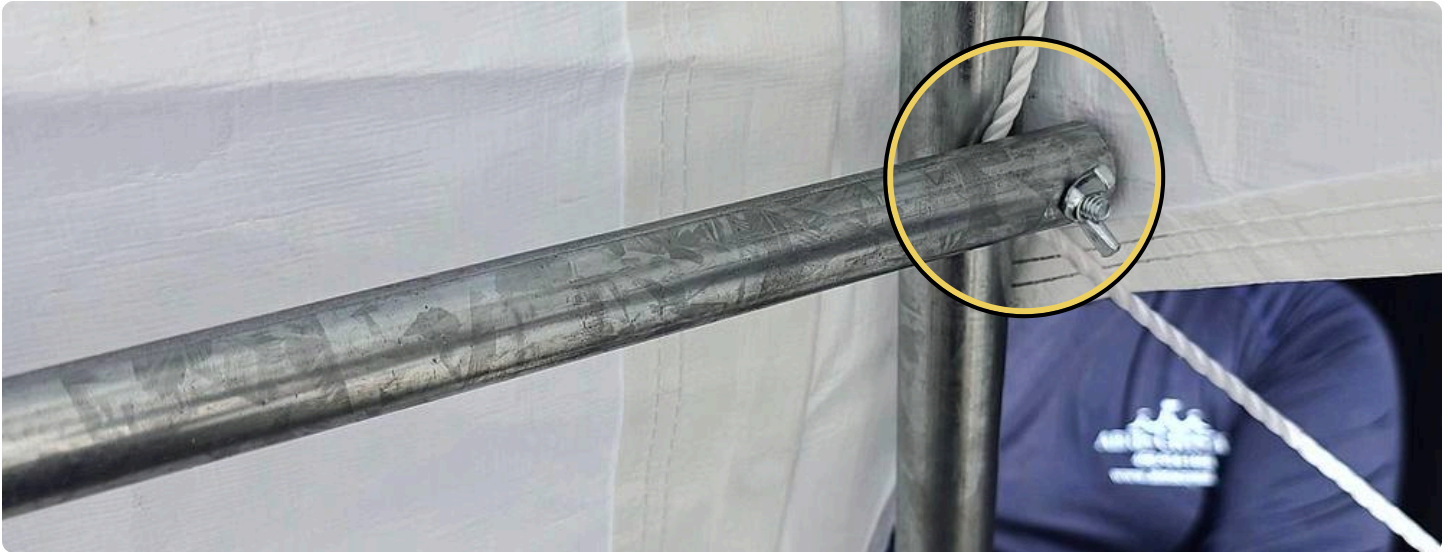
Corde bloquée entre le coin et l'entretoise / Rope locked between the corner and the spacer
