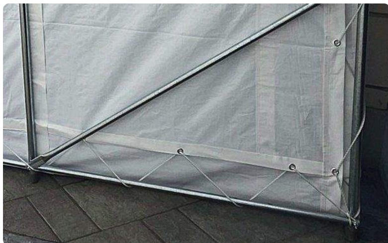
Résultat : la corde en zigzag, bien tendue
