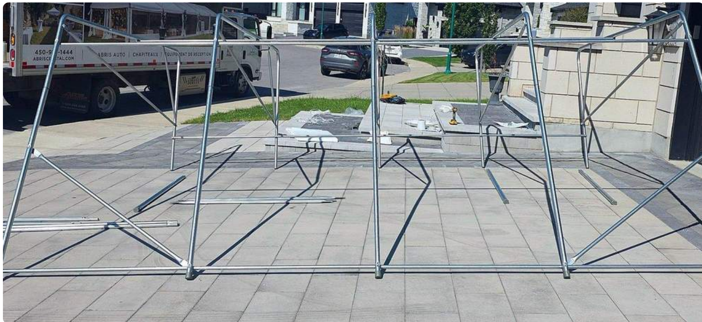
Bas côté sur ses pattes, haut côté encore au sol
