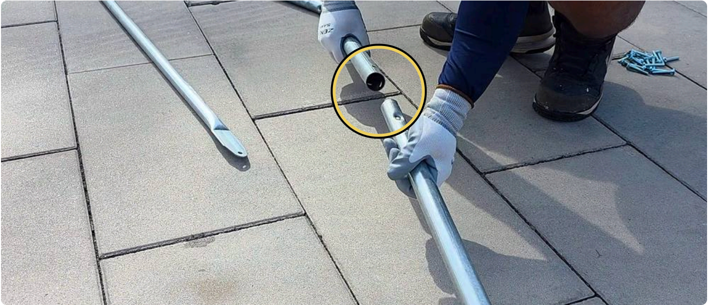
L'embout mâle entre dans l'embout femelle
