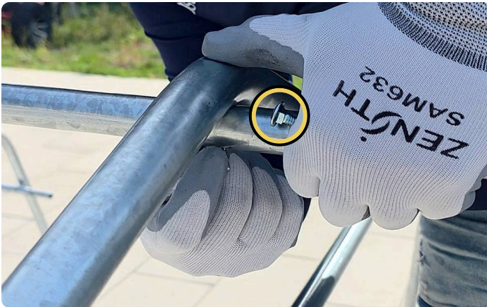
Entretoise boulonnée à l'arche : B2 + W1
